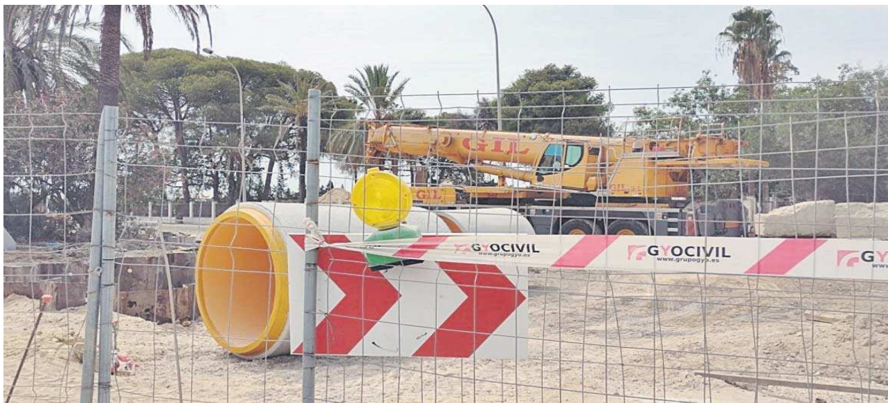
Una imagen de los trabajos que se ejecutan en la Rotonda de La Puntilla, a cargo de la empresa Gyocivil.
