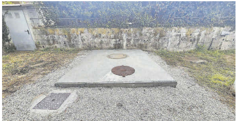
Nueva bomba en el saneamiento del colegio CEIP Tirán. | FdV
